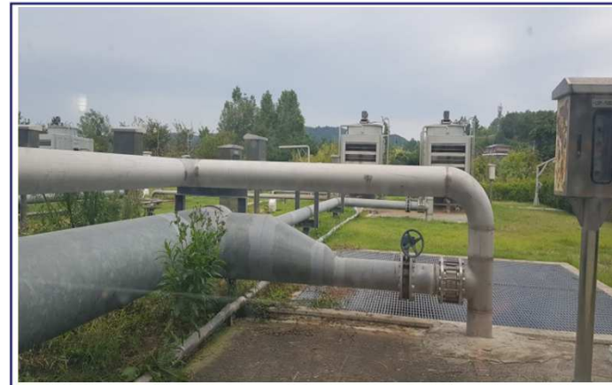
생물반응조 유입배관 설치
