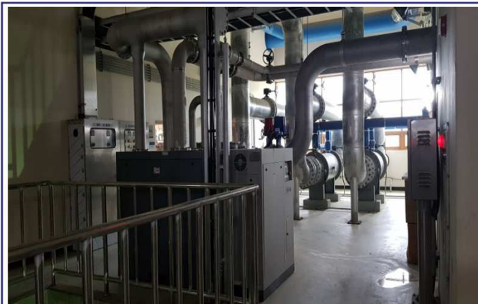
악취제거용 송풍기 설치
